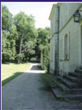
Salles de séminaires avant rénovation.
